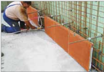
Vorbereitung zum Einbau in den Betonkeller
