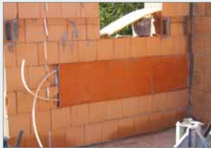
Einbau als Wandelement
